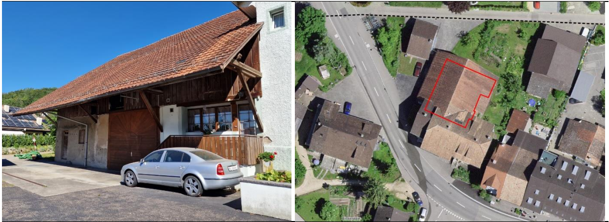
Abb. 28: Hauptstrasse 16, Scheune (Jermann AG 2023 | GeoView BL 2023)
