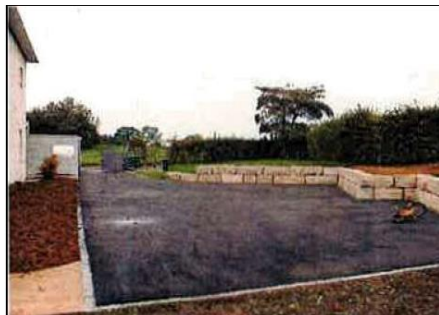
Asphaltbelag und Stützmauern
